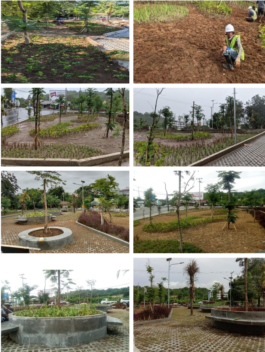
Gambar 4.15 Hasil Pekerjaan Penanaman Semak dan Rumput Lokal
