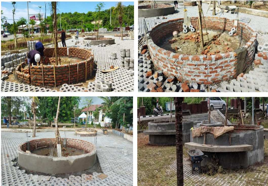
Gambar 4.9 Proses Pembuatan Bangku Taman
