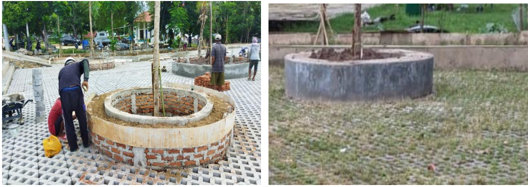
Gambar 4.8 Proses Pembuatan Planter Box
