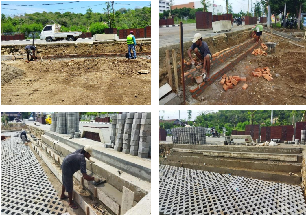
Gambar 4.10 Proses Pembuatan Trap Tangga
