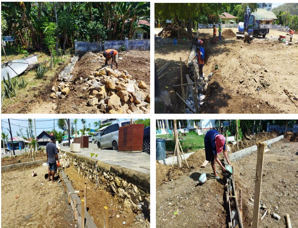
Gambar 4.6 Proses Pekerjaan Pondasi Batu Kali dan Kanstin
