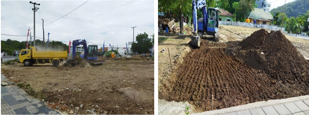
Gambar 4.5 Proses Kegiatan Perataan Tanah
