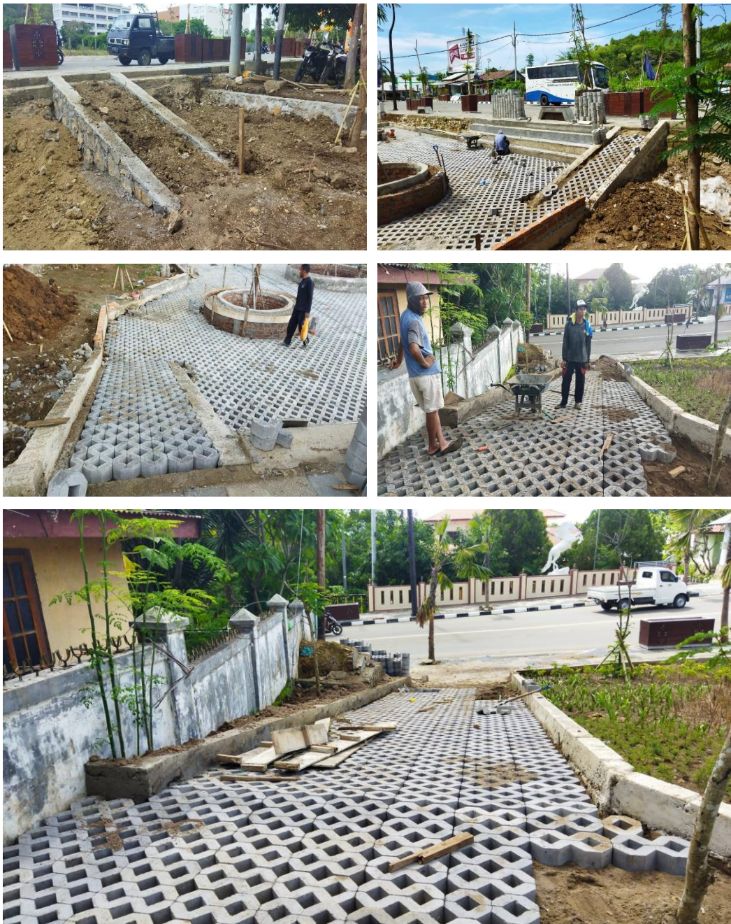
Gambar 4.12 Proses Pekerjaan Ram 1 dan Ram 2
