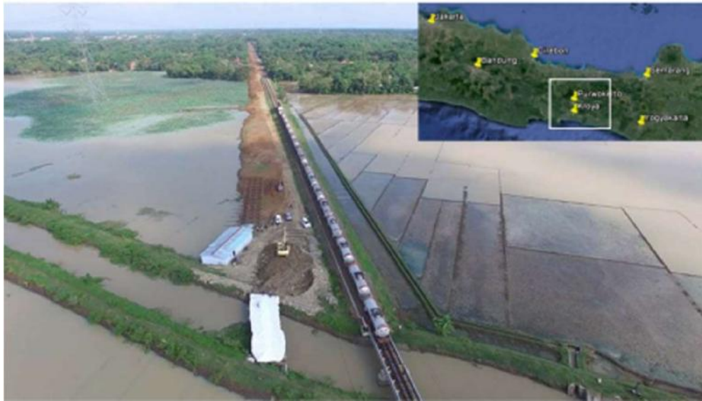
Gambar 1-1 Lokasi Pekerjaan Pembuatan Timbunan Badan Jalan Rel Jalur KA Antara Purwokerto Dan Kroya (Promisco, 2016)
