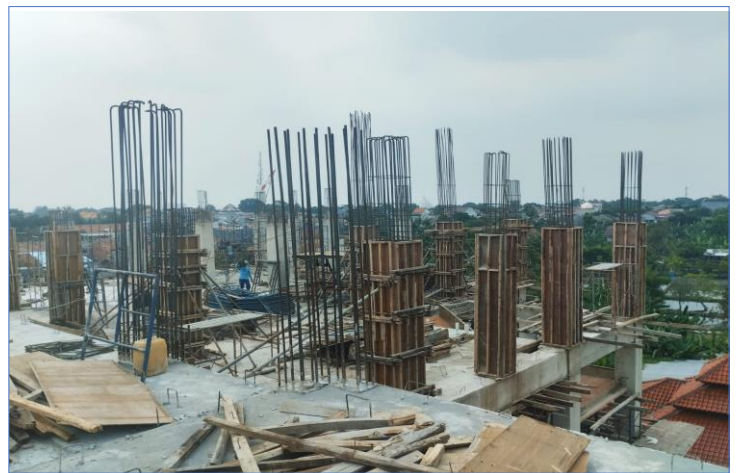
Pengerjaan pembuatan Bekisting di lantai 3
