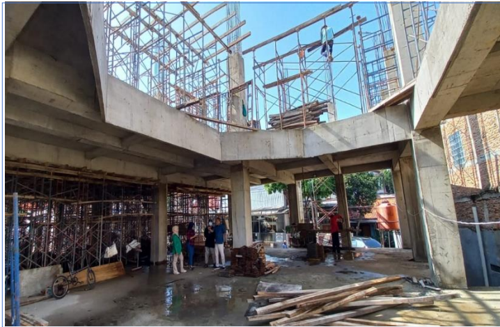
Pengamatan hasil Pengerjaan pengecoran lantai 2
