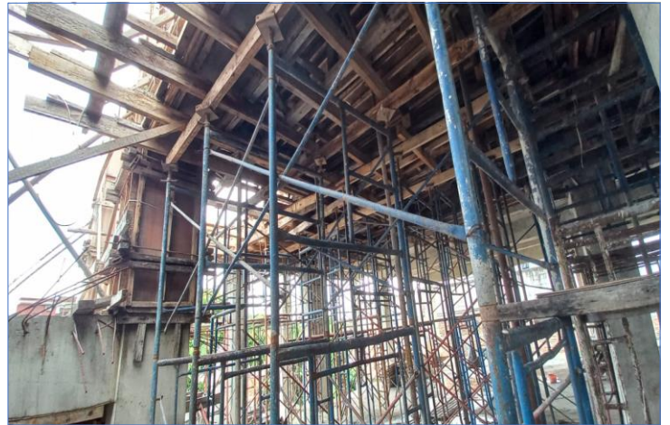
Pengerjaan Bagesting untuk lantai 3 sisi Timur
