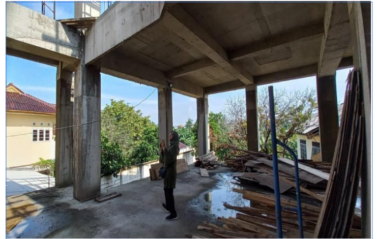
Pengamatan hasil Pengerjaan pengecoran lantai 2
