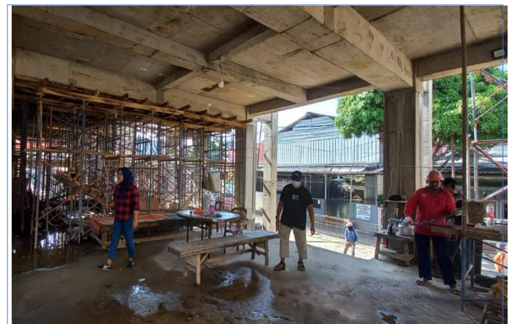
Atap lantai satu bagian sisi utara selesai di cor
