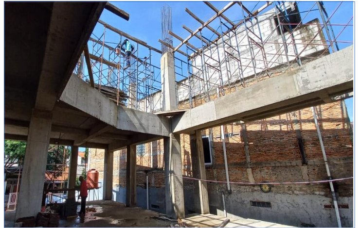
Pengerjaan Bekisting untuk lantai 2
