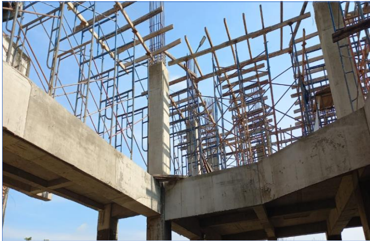
Pengerjaan Bekisting untuk lantai 2
