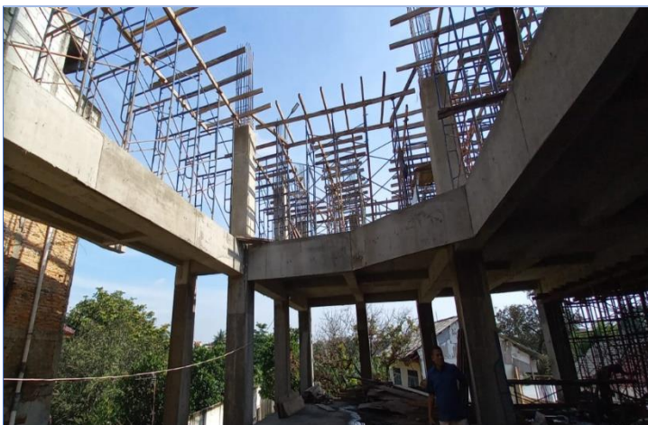
Atap lantai satu bagian sisi utara selesai di cor
