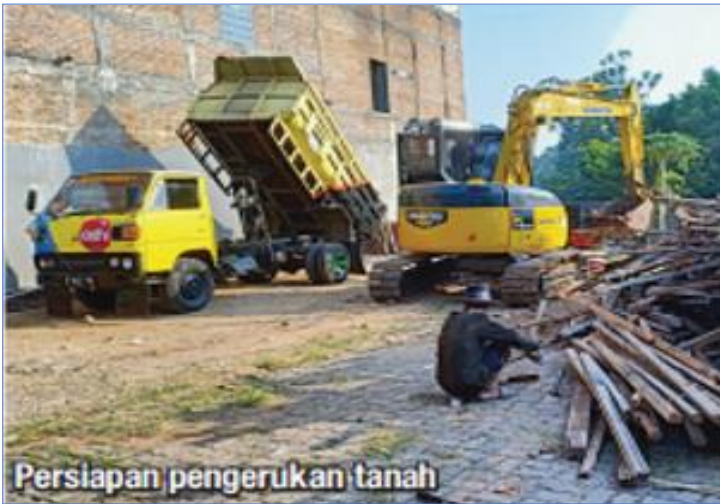
Pengerukan tanah untuk semi basment
