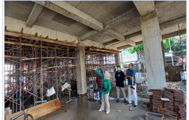
Kondisi lantai satu bagian sisi utara selesai di cor
