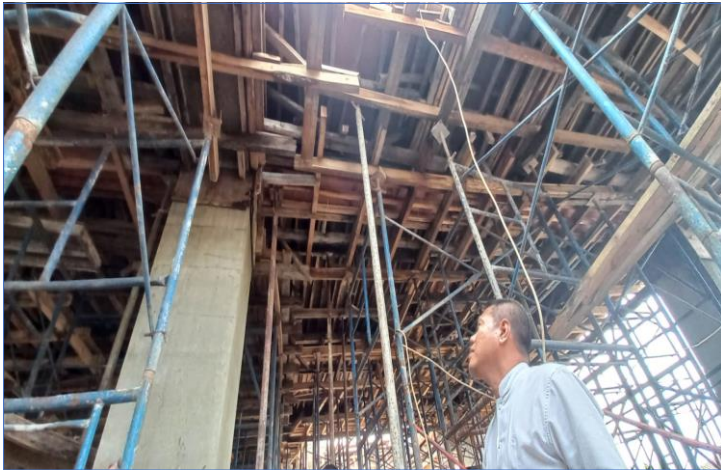
Pengerjaan Bagesting untuk lantai 3 sisi Timur
