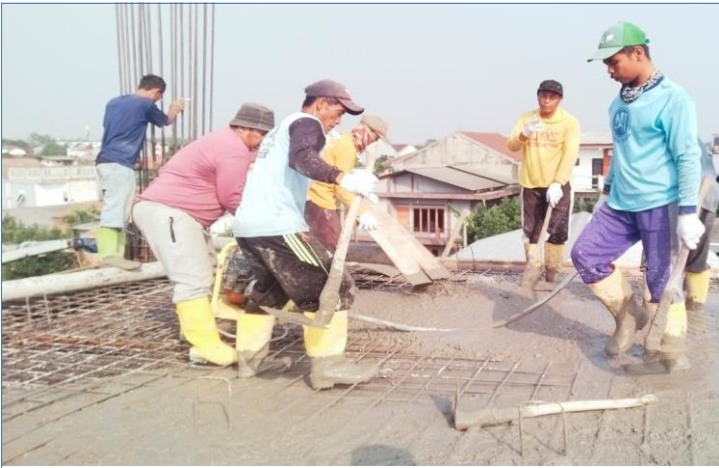
Pengerjaan Pengecoran dan pembuatan Bekisting di lantai 3
