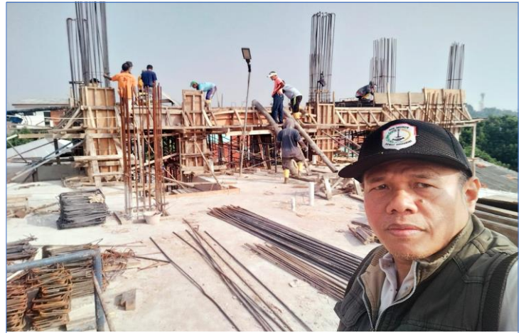
Pengerjaan Pengecoran dan pembuatan Bekisting di lantai 3
