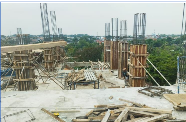
Pengerjaan pembuatan Bekisting di lantai 3
