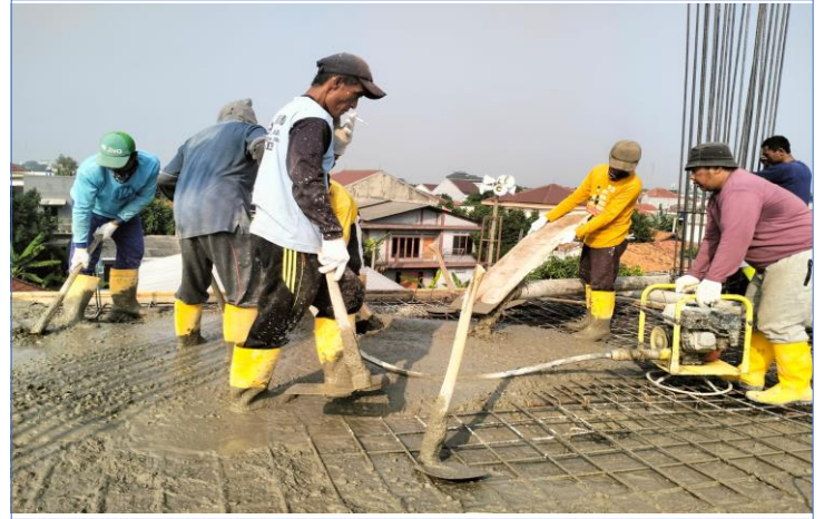
Pengecoran pada pembangunan Masjid lantai 3
