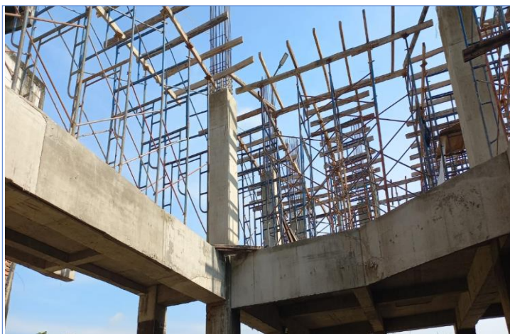
Pengerjaan Bekisting untuk lantai 2 dan Tiang bangunan bagian sisi utara
