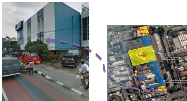
Gambar 2 : Bangunan 1, Kantor PT. Karya Teknik Multifinance Sumber : Dokumen Pribadi, Survey Lapangan, 2019
