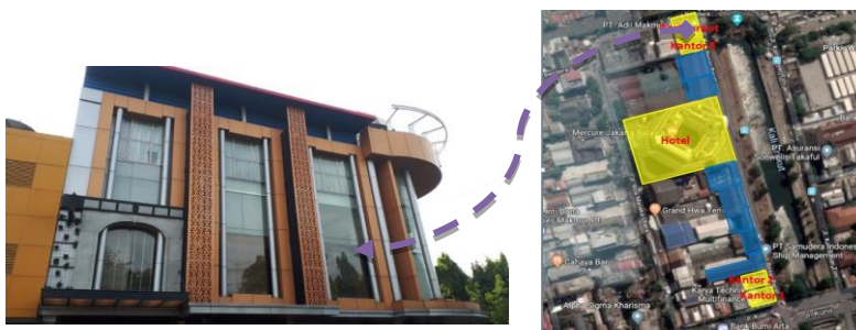
Gambar 6: Bangunan 5, Queen Palace Restaurant Sumber : Dokumen Pribadi, Survey Lapangan, 2019
