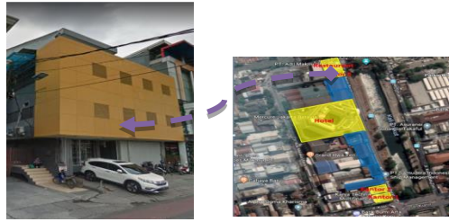
Gambar 4: Bangunan 3 , Kantor PT. Adil Makmur Fajar (Sumber : Dokumen Pribadi, Survey Lapangan, 2019)
