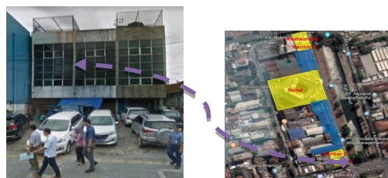
Gambar 3 : Bangunan 2, Kantor dan Pertokoan Sumber : Dokumen Pribadi, Survey Lapangan, 2019
