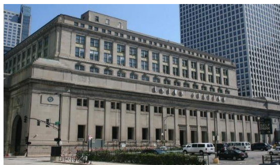
Gambar 3. 5 : Chicago stasiun kereta api Sumber : Google
