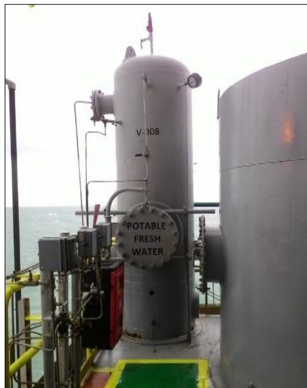
Gambar 2. 10 Tangki tekan yang dilengkapi dengan automatic sensor.
