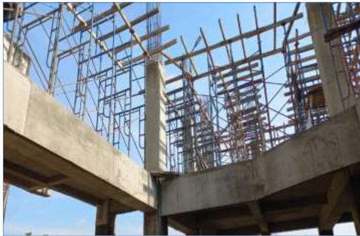
Pengerjaan Bekisting untuk lantai 2
