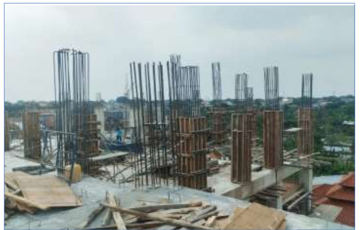
Pengerjaan pembuatan Bekisting di lantai 3
