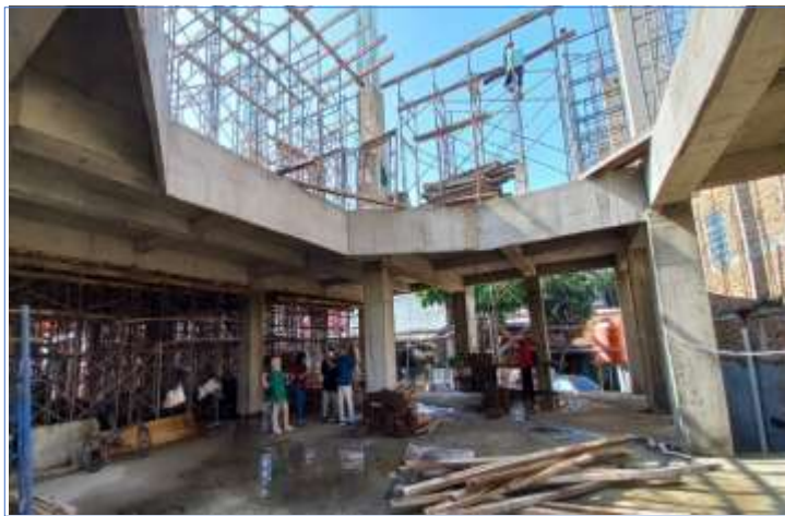
Pengamatan hasil Pengerjaan pengecoran lantai 2
