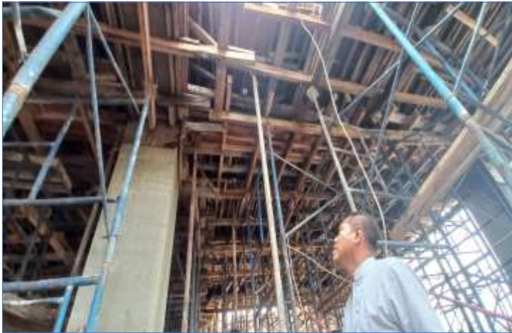
Pengerjaan Bagesting untuk lantai 3 sisi Timur
