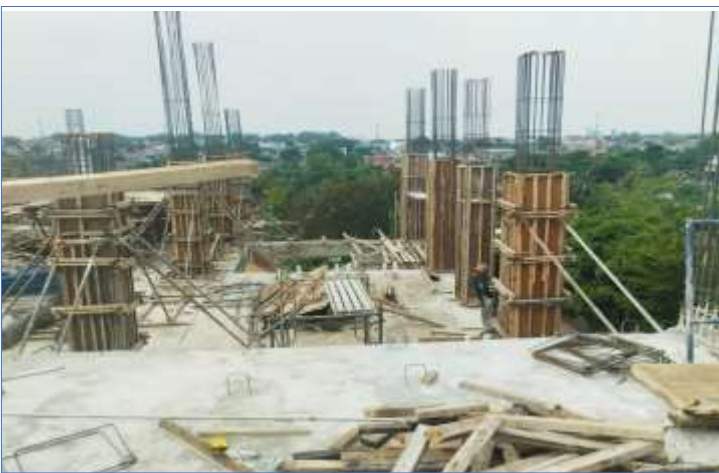
Pengerjaan pembuatan Bekisting di lantai 3
