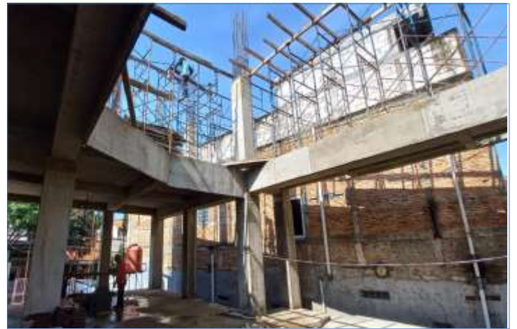
Pengerjaan Bekisting untuk lantai 2
