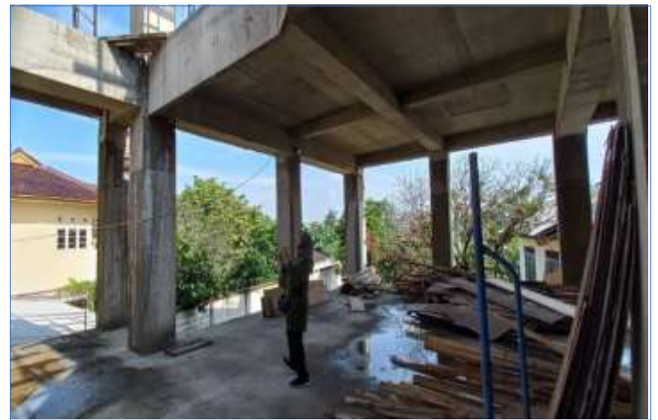
Pengamatan hasil Pengerjaan pengecoran lantai 2
