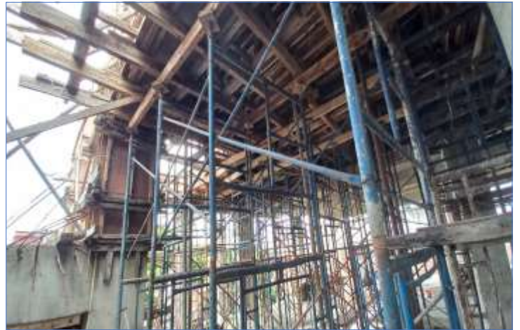
Pengerjaan Bagesting untuk lantai 3 sisi Timur
