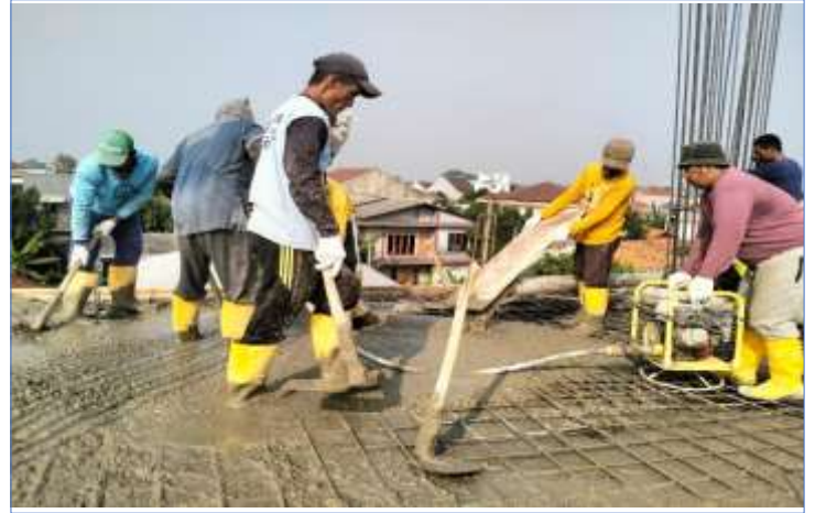
Pengecoran pada pembangunan Masjid lantai 3
