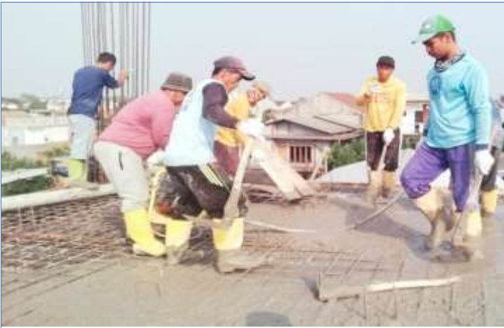
Pengerjaan Pengecoran dan pembuatan Bekisting di lantai 3
