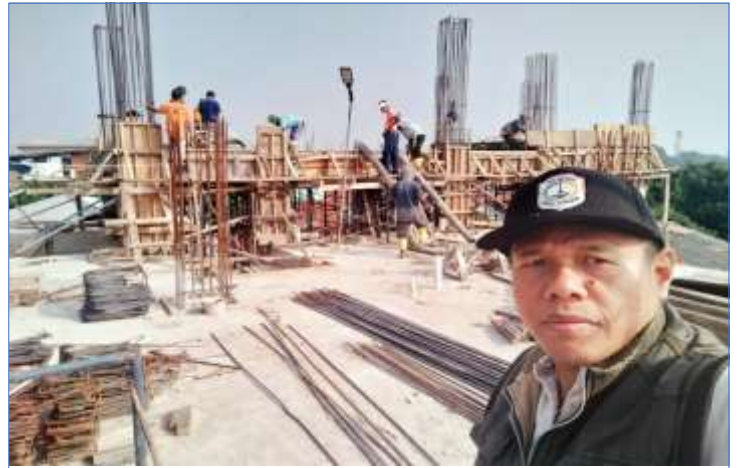
Pengerjaan Pengecoran dan pembuatan Bekisting di lantai 3
