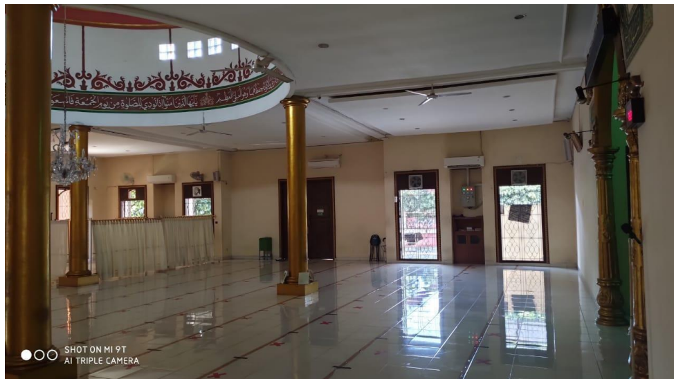
Gb 6. Bukaa dan ventilasi eksisting
