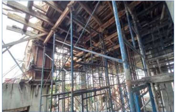
Pengerjaan Bagesting untuk lantai 3 sisi Timur
