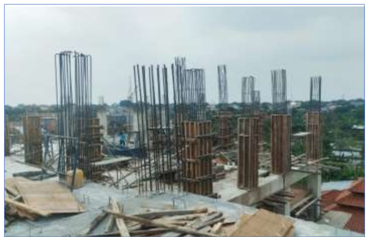
Pengerjaan pembuatan Bekisting di lantai 3
