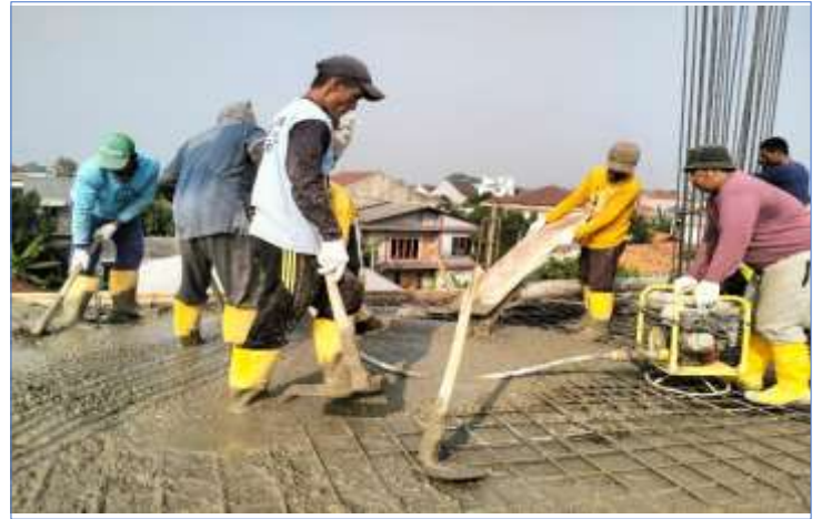
Pengecoran pada pembangunan Masjid lantai 3
