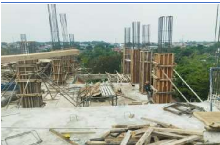
Pengerjaan pembuatan Bekisting di lantai 3
