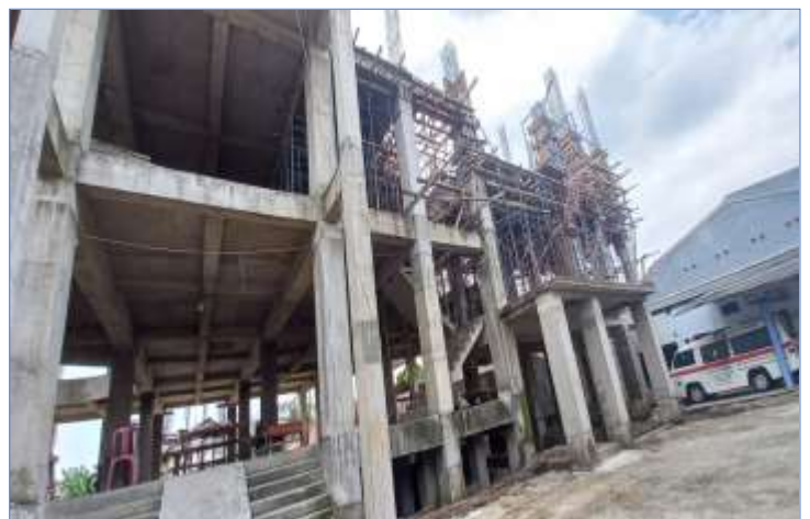
Pengerjaan Bekisting untuk lantai 3 sisi Timur Tampak dari Jalan
