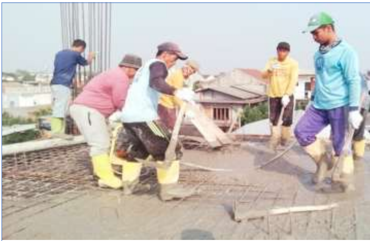
Pengerjaan Pengecoran dan pembuatan Bekisting di lantai 3
