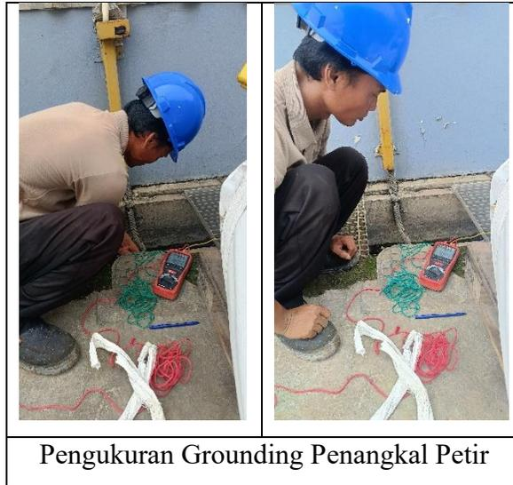
Pengukuran Grounding Penangkal Petir
