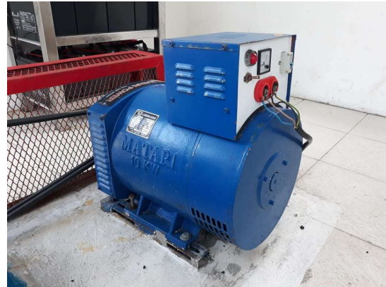
Gambar 11. Generator PLTMH kapasitas 10kW
