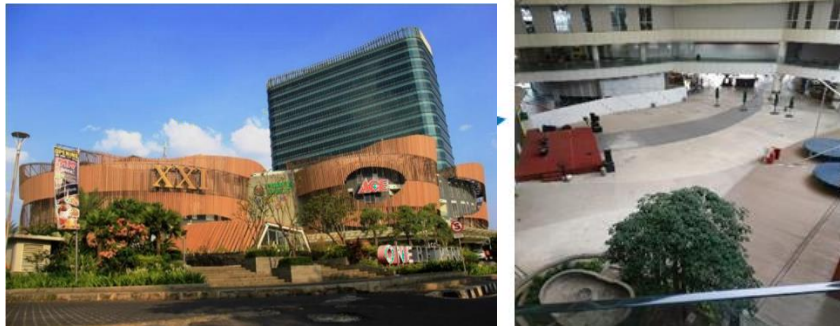
Gambar 1 : Eksterior dan interior Bangunan One Bellpark
