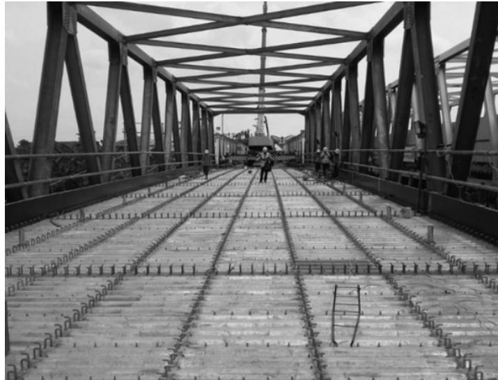
Gambar 1.9 Pelat Lantai Jembatan
