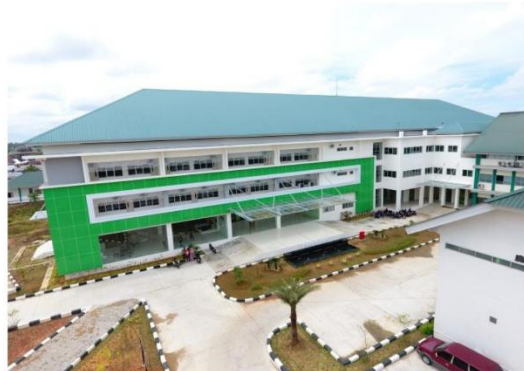
Pembangunan Gedung Rumah Sakit Sultan Syarif Mohamad Alkadrie
