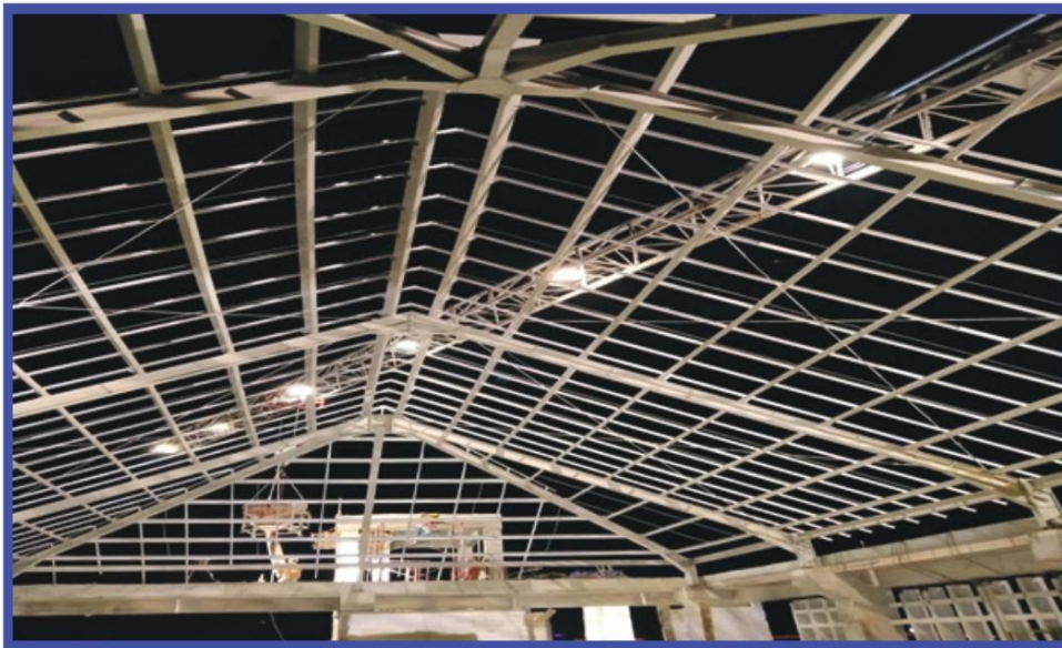
Konstruksi baja atap kantor Otoritas Jasa Keuangan (OJK) - SOLO
