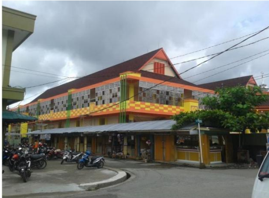
Pembangunan Pasar Raya Sintang Tahap II TA 2015
