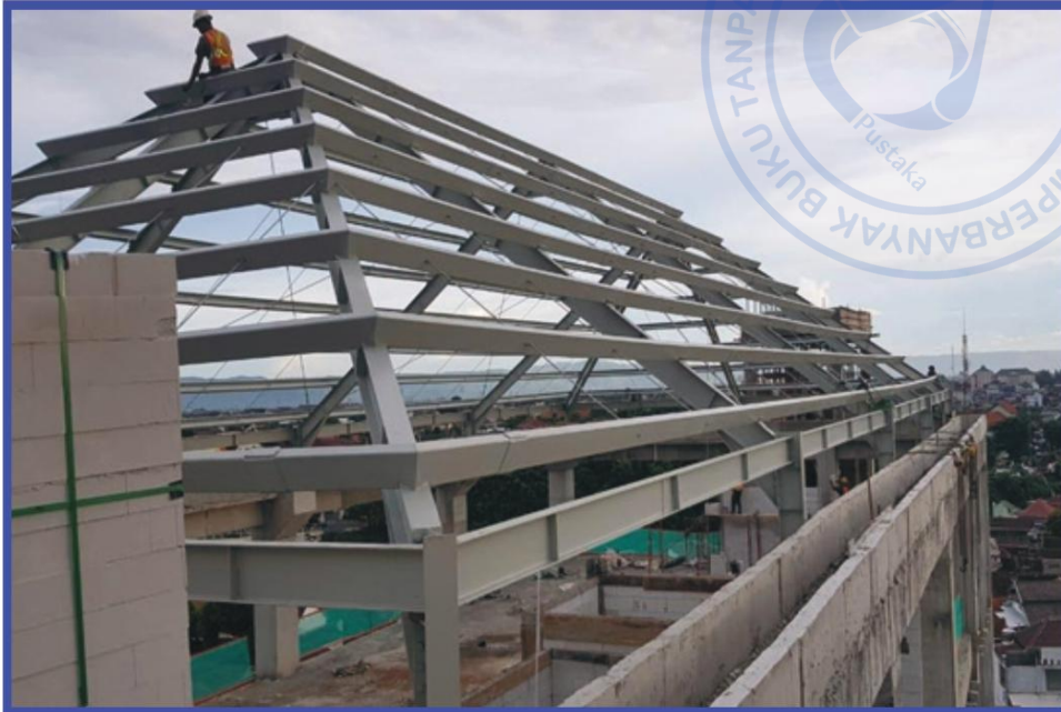
Konstruksi baja atap kantor Otoritas Jasa Keuangan (OJK) - YOGYAKARTA
