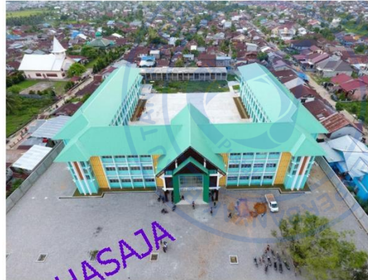
Pembangunan Gedung SMP Negeri 13 Pontianak
