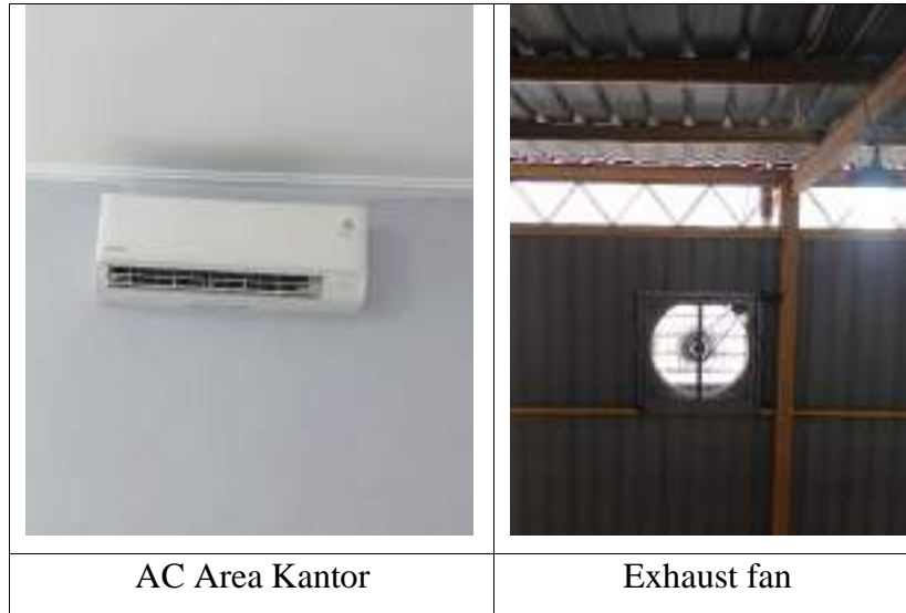
Gambar 4. 8 Penghawaan Buatan Gedung PT. Sumatera Hakarindo Sumber: Hasil Analisa di Lokasi Kegiatan
