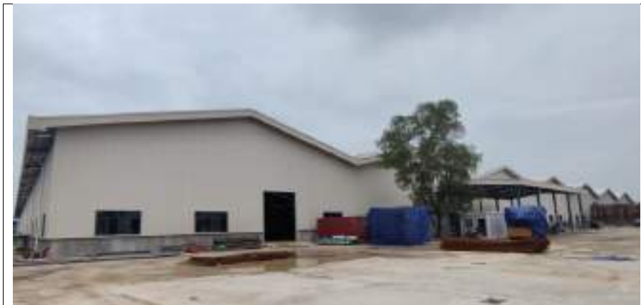
Tampak Bangunan Gedung
