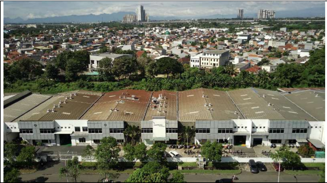
Tampak Bangunan Gedung
