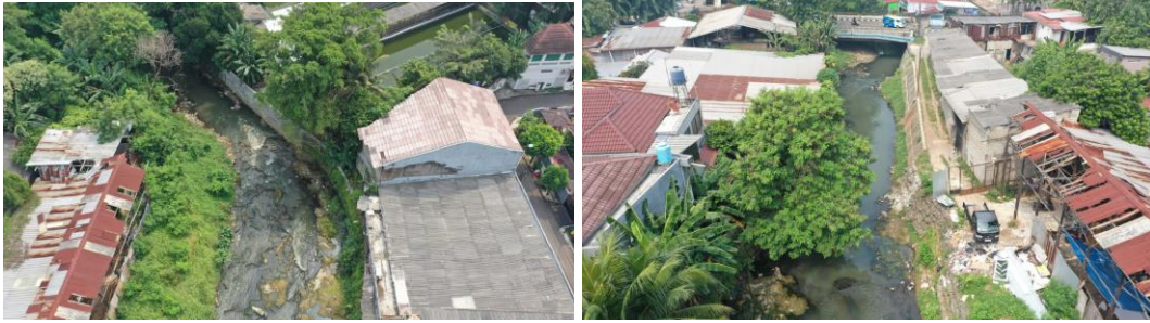
Gambar 3. 42. Kondisi aliran Kali Jatikramat di tengah permukiman
