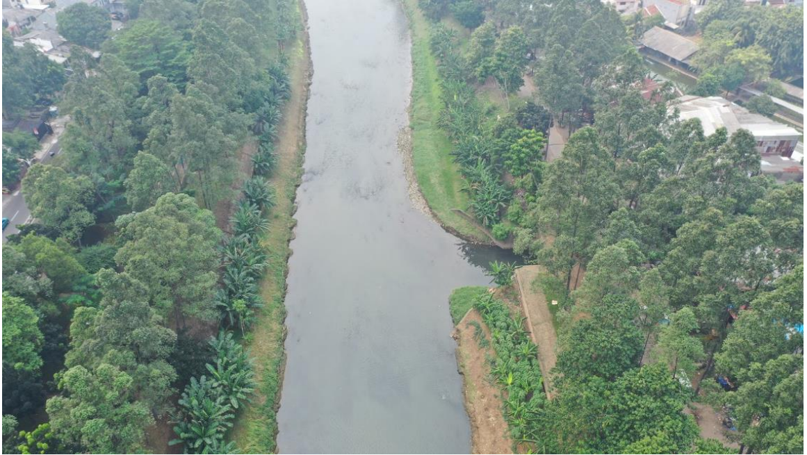
Gambar 3. 38. Banjir Kanal Timur sebagai muara aliran Kali Jatikramat
