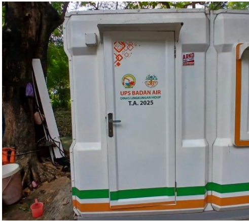
Gambar 3. 15. Fasilitas UPS di Aliran Sungai Grogol
