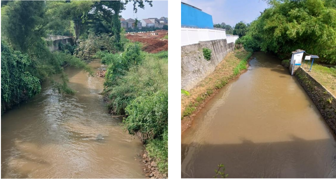
Gambar 3. 47. Aliran sungai Angke bagian tengah di Jembatan Ciater
