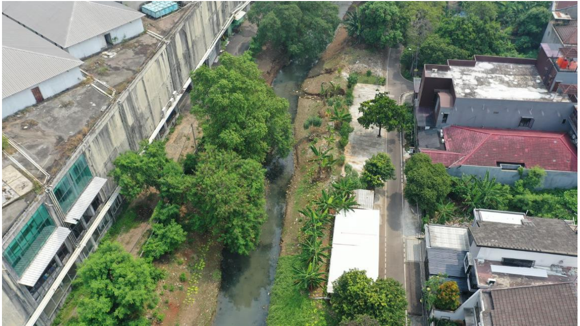
Gambar 3. 31. Kondisi aliran Kali Jatikramat sebelum melalui di bawah persimpangan aliran Kalimalang dekat dengan IPA Buaran
