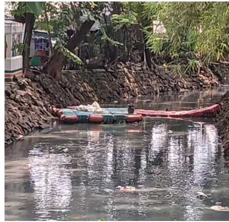
Gambar 3. 16. Pemasangan Palka di aliran Sungai Grogol
