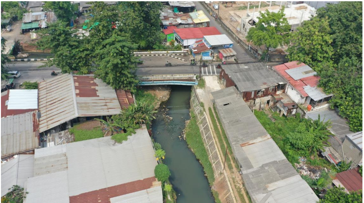
Gambar 3. 41. Kondisi aliran Kali Jatikramat di tengah permukiman sebelum bertemu dengan Banjir Kanal Timur
