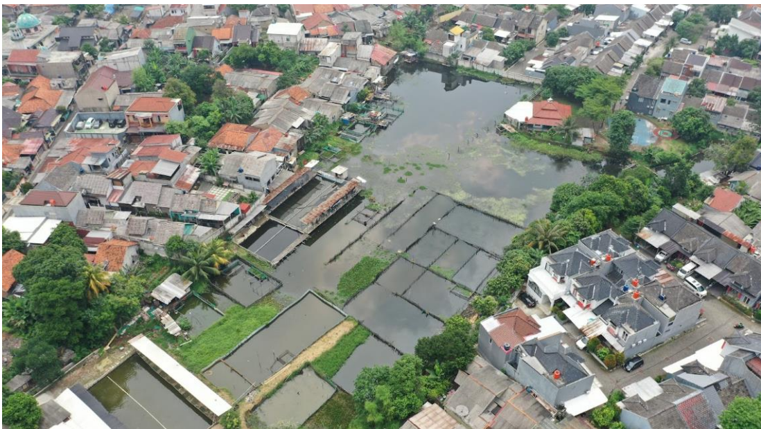
Gambar 3. 4. Kondisi bagain permukiman di hulu Sungai Grogol
