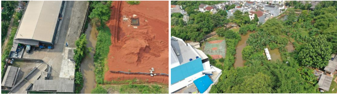
Gambar 3. 49. Kondisi aliran sungai Angke bagian tengah di Jembatan Ciater Kota Tangerang Selatan
