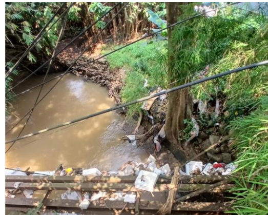
Gambar 3. 51. Sisa Sampah pada aliran Sungai Angke bagian Tengah di Jembatan Jelupang
