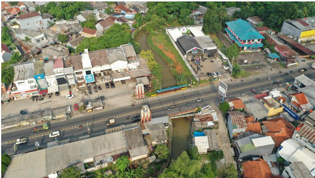
Gambar 3. 45. Lokasi survei Sungai Angke di jembatan perbatasan Kota Depok dan Kabupaten Bogor di Jalan raya Parung – Ciputat
