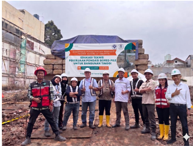
Gambar 4. Kunjungan Lapangan (Implementasi Pekerjaan Bored Pile)
