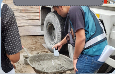
Pengecekan Suhu Beton
