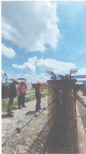
Gambar : Sosialisasi Pembangunan Jembatan T5 dengan Precast I Girder kepada Masyarakat Kelurahan Temmapaduae Kecamatan Marusu Kabupaten Maros .
