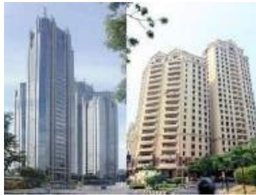
Gedung Bursa Efek Indonesia & Apartemen 1998
