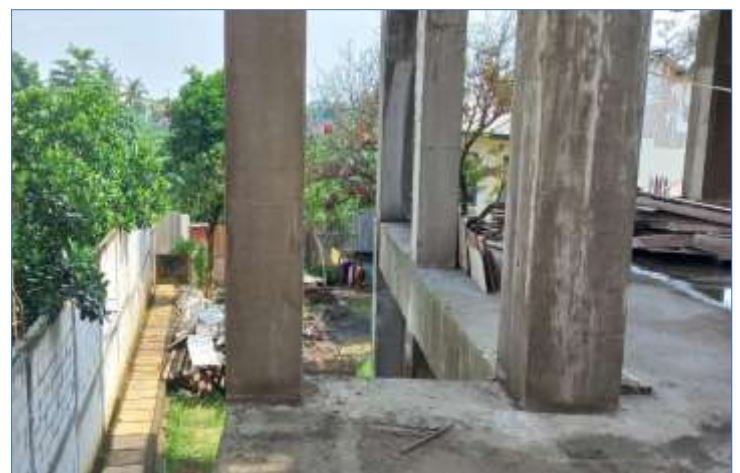
Pengerjaan Bekisting untuk lantai 2 dan Tiang bangunan bagian sisi utara
