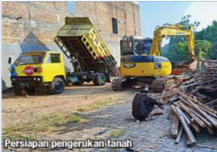
Pengerukan tanah untuk semi basment
