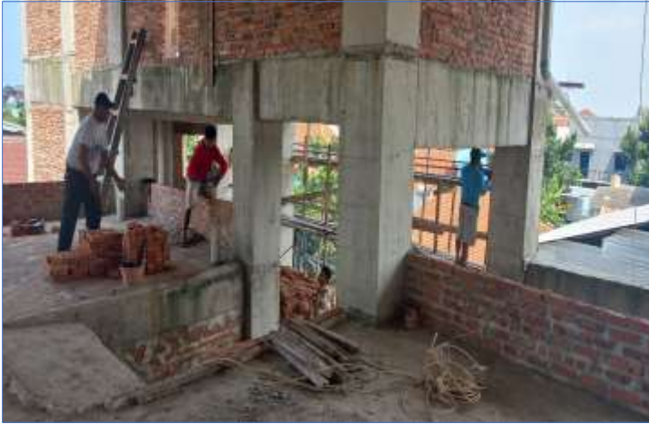
Pengerjaan Dinding Masjid Lantai 2
