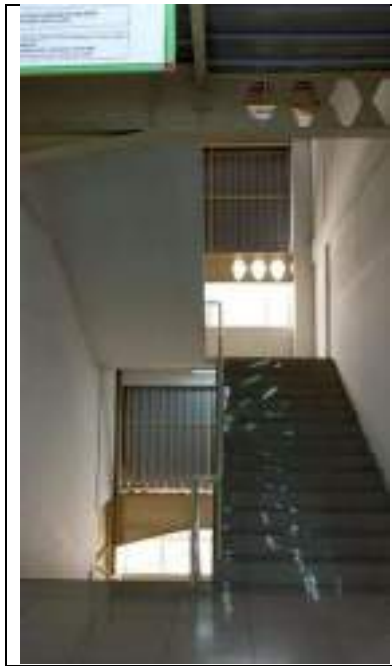
Gambar 4. 26 Tangga pada Bangunan Sumber: PT. Dharma Polimetal, Tbk.
