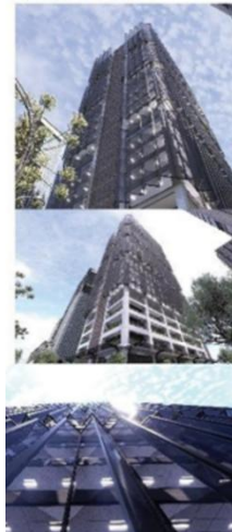
Gambar 13. Fasad Bangunan dengan Secondary Skin Motif Batik Sumber: Data Pribadi, 2025
