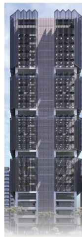
Gambar 12. Fasad Bangunan dengan Secondary Skin Motif Batik Sumber: Data Pribadi, 2025
