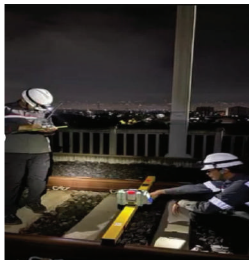
Gambar 3. Pengukuran Statis Parameter OCS
