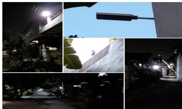
Gambar 5. Kondisi lingkungan dan lampu setelah proses pemasangan.
