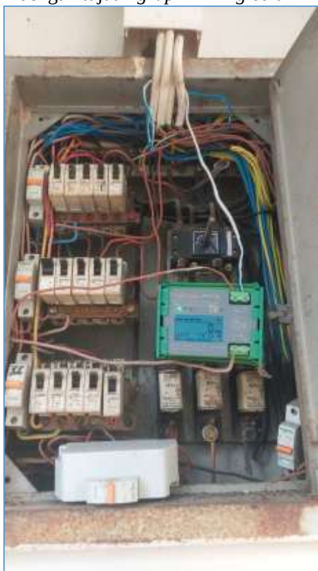
Gambar 8 Pemasangan perangkat IOT PM1611Q pada MCB
