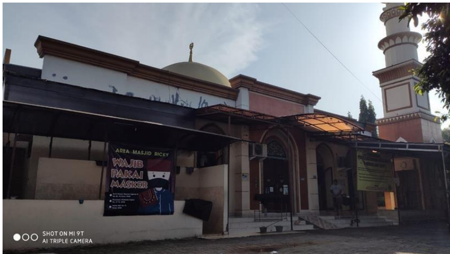
Gb 8. Tampak luar dan kondisi vegetasi eksisting
