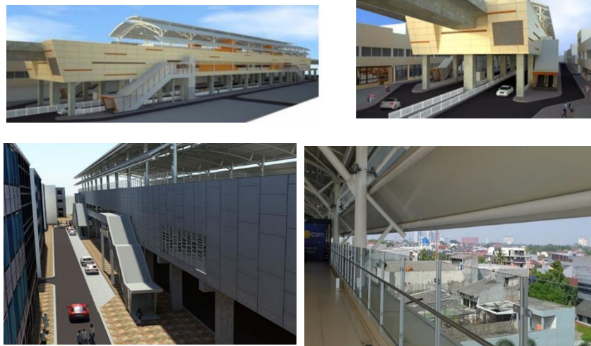
Gambar 5. Kondisi fasad Stasiun MRT H. Nawi (Sumber: hasil survey, 2020)
