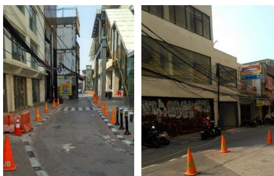
Gambar 2. Kondisi fisik bangunan di sekitar stasiun MRT (Sumber: hasil survey, 2020)
