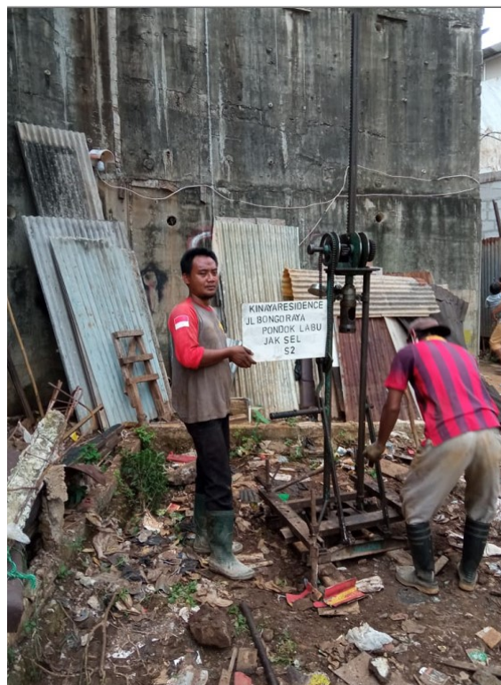
Gambar: Photo titik Sondir S2 daerah dasar dinding penhan tanah
