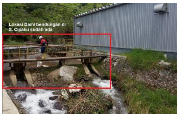
Gambar 6.9 Lokasi Dam/water intake di Sungai Cipaku untuk PLTMH
