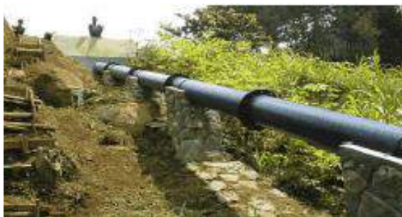
Gambar 6.13 Contoh fasilitas penstock (pipa pekat) pada PLTMH
