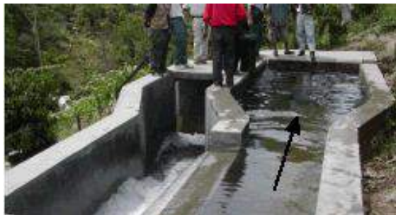
Gambar 6.12 Contoh fasilitas headtank (bak penenang) pada PLTMH
