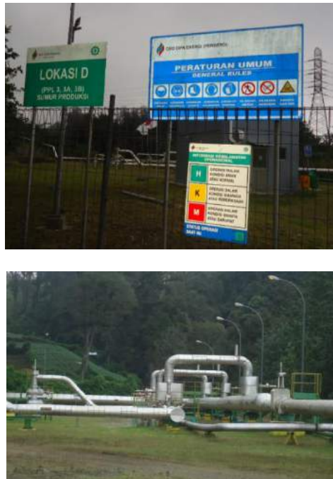
Gambar 2.4. Salah satu lokasi Well Pad (Lokasi D – Well 3, 3A, 3B)
