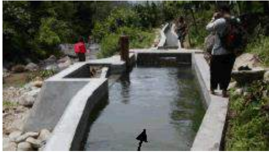
Gambar 6.10 Contoh fasilitas Settling basin (bak pengendap) pada PLTMH
