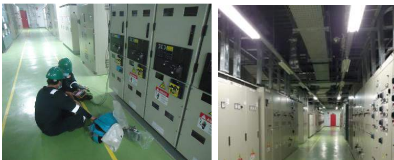
Gambar 4.5 Dokumentasi pengukuran di panel incoming auxillary PLTP Patuha
