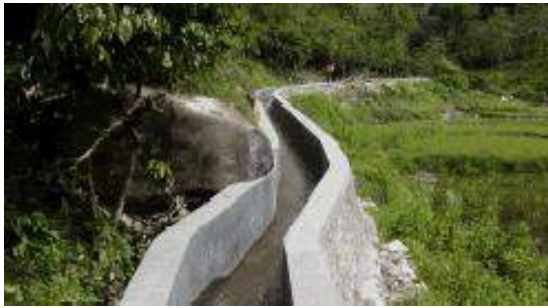
Gambar 6.11 Contoh fasilitas headrace (saluran pembawa) pada PLTMH
