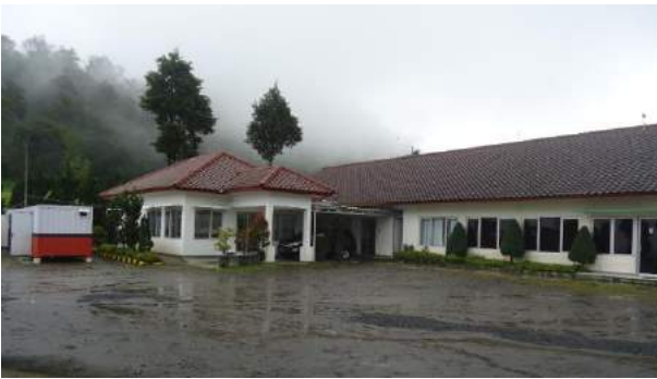
Gambar 2.19. Bangunan Kantor admin pembangkit (atas) dan kantor basecamp (bawah)
