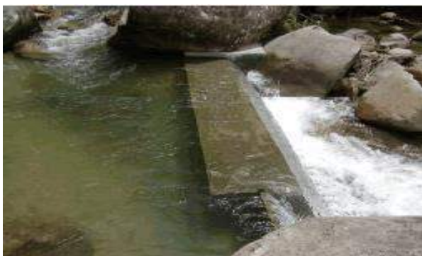
Gambar 6.8 Contoh Dam/ Water intake untuk PLTMH
