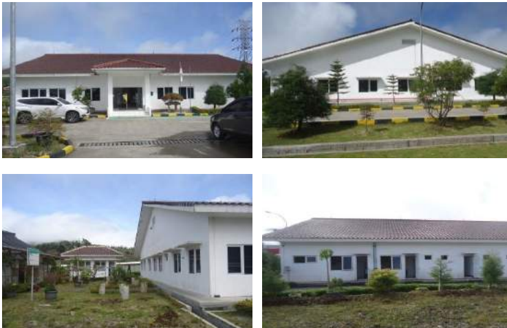
Gambar 5.15. Gedung Admin PLTP Patuha
