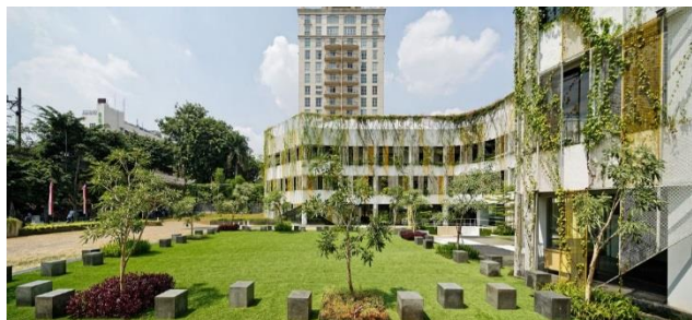
Gambar 7. Tampak Kanan (Sumber: Archdaily.com)
