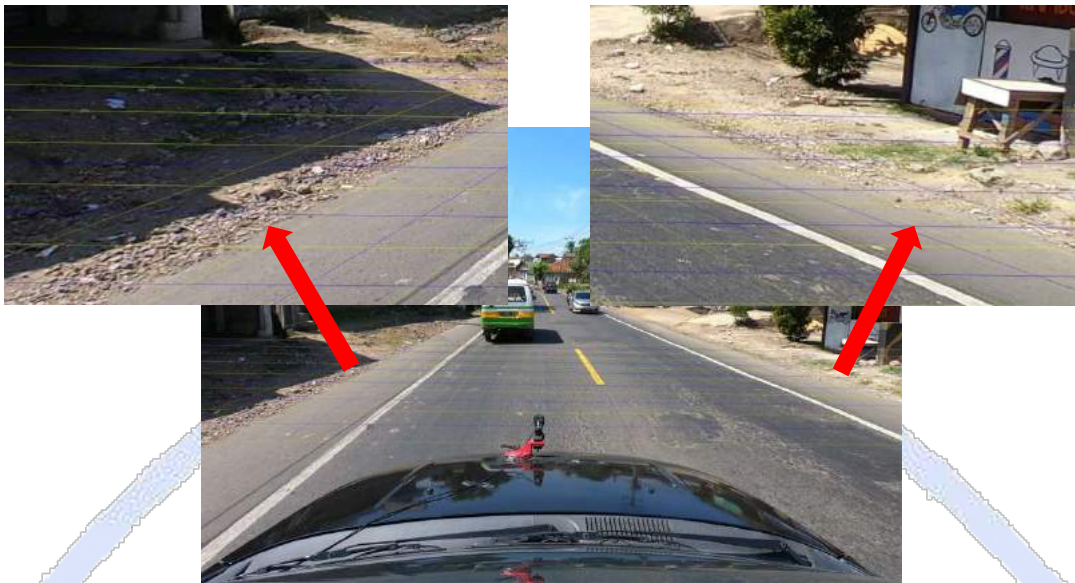
Gambar 4.16 Tidak terdapatnya Drainase Pada Segmen 3 STA (0+200 – 0+300)
