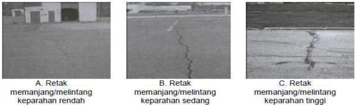
Gambar 2.20 Tingkat Keparahan Retak Memanjang/Melintang
