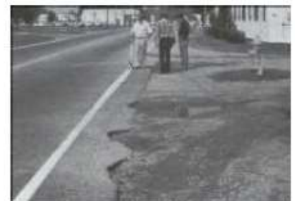
C. Retak tepi keparahan tinggi
