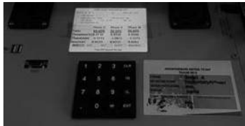
Gambar 4.5. Nilai Rasio pada Tap 3 Lcd Catat hasil data rasio yang muncul di layar display TTR. Setelah selesai maka alat bisa di off kembali. Data hasil pengukuran rasio transformator (TTR) pada tiap tap masing-masing fhasa ditunjukkan pada tabel 4.2.
