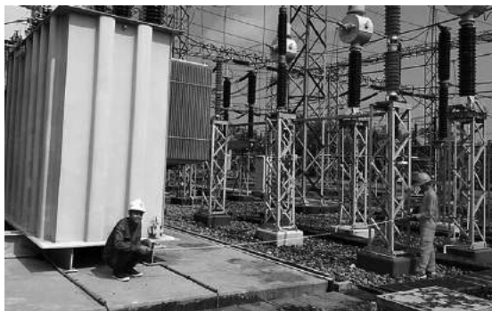
Gambar 13. Pengukuran jarak antar komponen di lapangan
