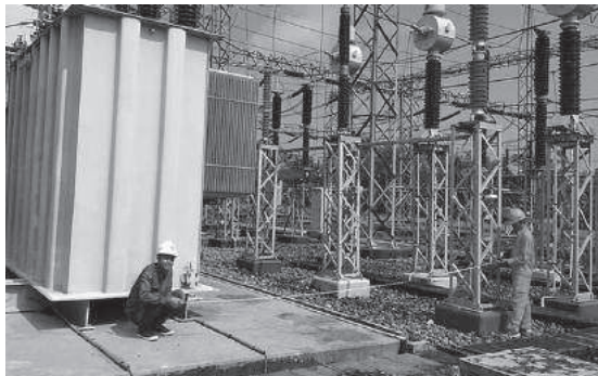
Gambar 13. Pengukuran jarak antar komponen di lapangan
