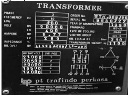
Gambar 12. Name Plate Transformator.
