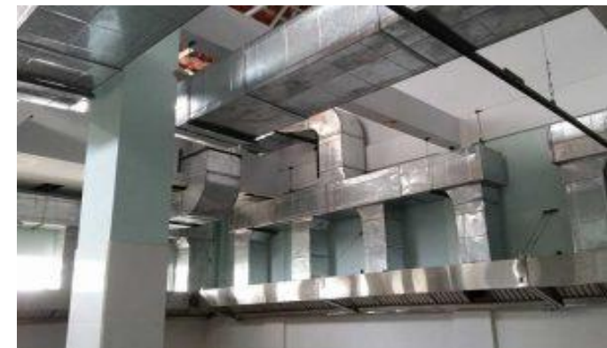
Instalasi Ducting pembuangan asap
