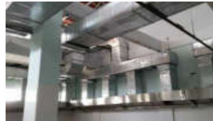
Instalasi Ducting pembuangan asap
