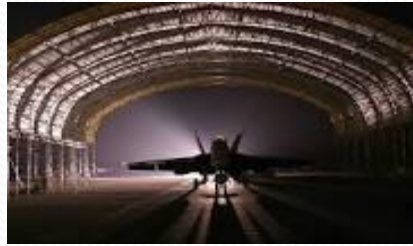
Bangunan dengan bentang panjang
