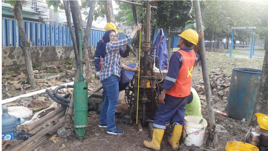
Gambar 3.4. Pengeboran dengan menggunakan alat bor lengkap
