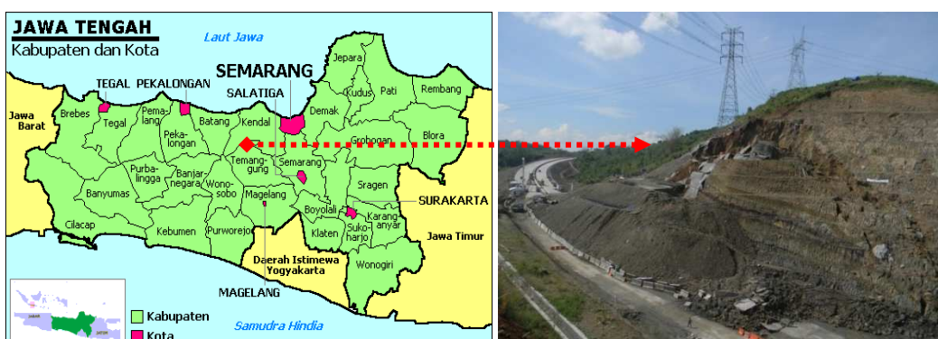
Gambar 1.6 Keruntuhan lereng clay shale di proyek jalan Tol Semarang Ungaran Bawen seksi STA 19+250 (Himawan, 2011)
