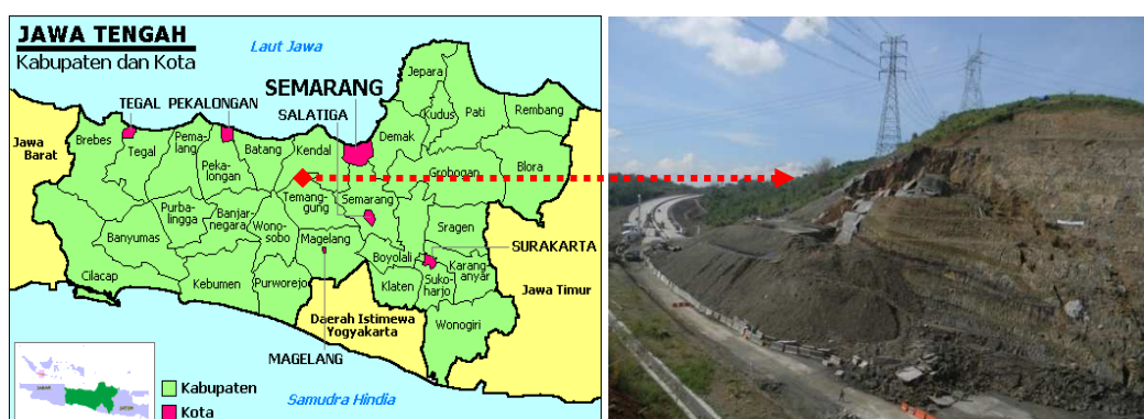
Gambar 1.5 Keruntuhan lereng clay shale di proyek jalan Tol Semarang Ungaran Bawen seksi STA 19+250 (Himawan, 2011)
