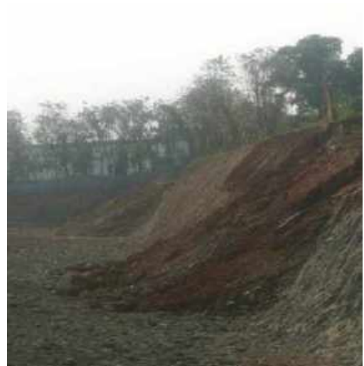
Gambar 4.11 foto psoses cutting tanah sampai kelongsoran tanah
