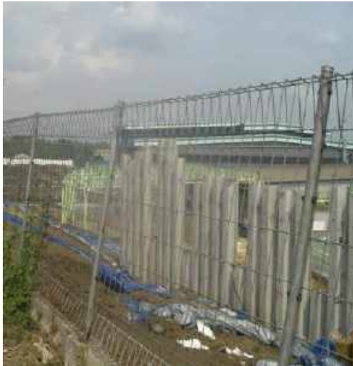
Gambar 4.15 foto psoses turap sheet pile selesai dipasang sampai terjadinya kemiringan turap sheet pile
