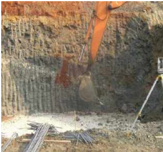
Gambar 4.11 foto psoses cutting tanah sampai kelongsoran tanah
