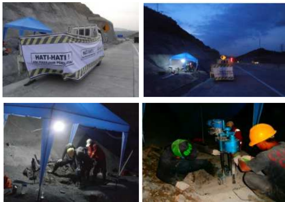
Gambar 4.13 Pekerjaan pengambilan sampel di Semarang Bawen dilakukan hingga larut malam untuk menghindari pelapukan pada lubang galian
