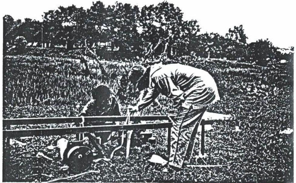
Gambar III.7 Pengukuran tinggi muka air tanah pada lubang bor  $\phi 4"$ .
