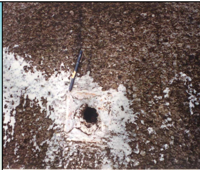
Punching Failure Antara Mur dan Plat Baja
