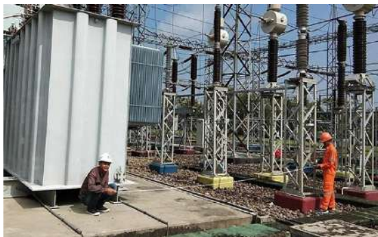
Gambar 13. Pengukuran jarak antar komponen di lapangan
