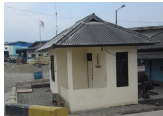
Perlu adanya pos jaga di setiap sudut jalan Kawasan Braga
