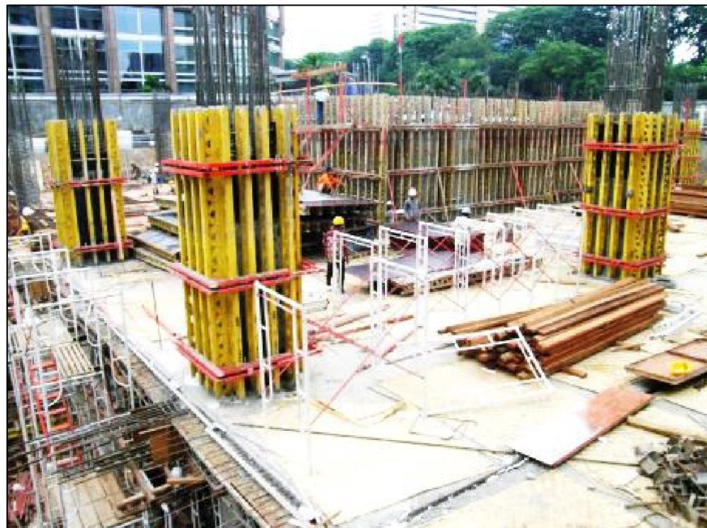
Gambar 11.A.5. Bekisting pra cetak (Sumber : strong Indonesia.com)
